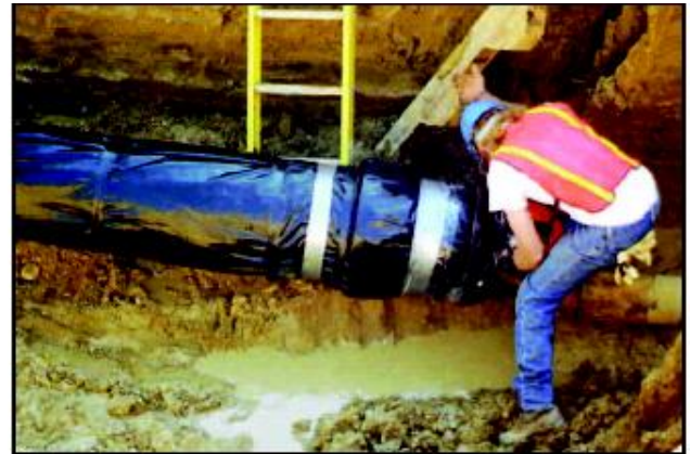
Рисунок 6.22 Покрытие труб полиэтиленовым рукавом.
