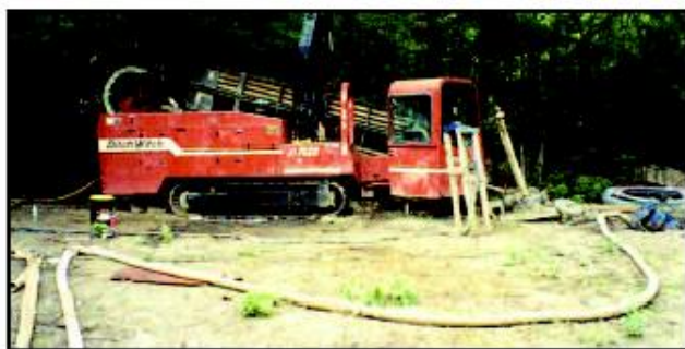
Рисунок 6.17 Прокладка трубопровода методом горизонтально направленного бурения.
