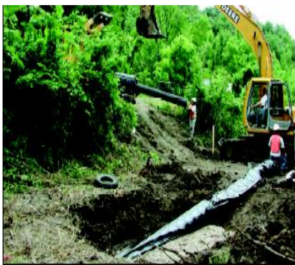
Рисунок 6.24 Картриджный метод укладки труб.
